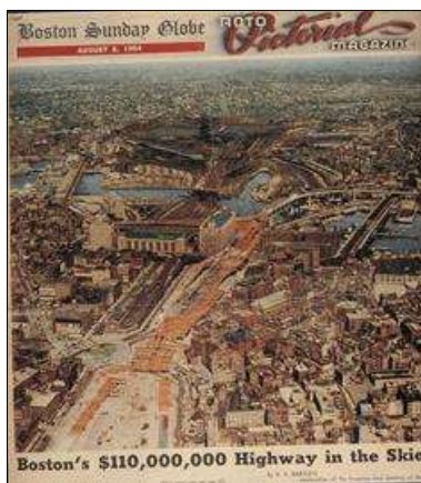
図-3 高架高速道路 建設中（1954年）
