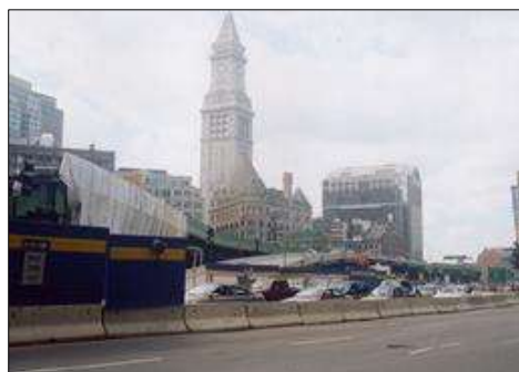
図-7 高架高速道路 撤去工事中（2004年）
