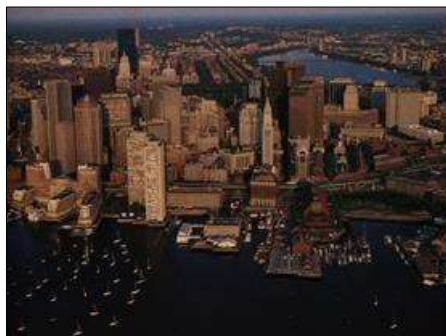
図-4 高架高速道路 供用中
