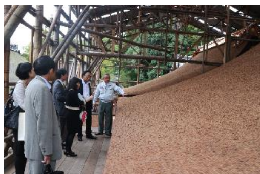
本殿檜皮葺屋根 葺替完了直後の視察
