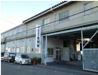
金剛組 関西加工センター（堺市）：ここで全ての部材を加工して、現場に持ち込むことで建築レベルを均等に保っている。
